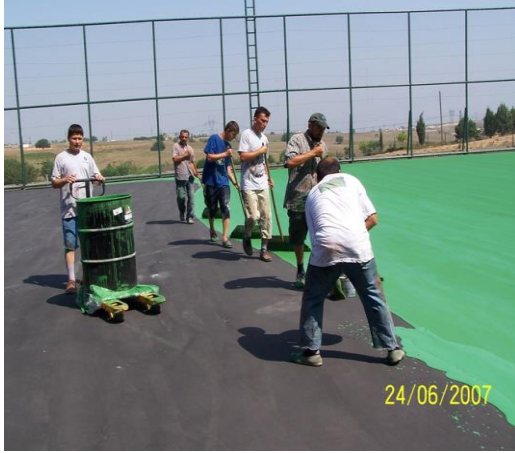
RUBBER ÜZERİ CUSHİON KATMANLI AKRİLİK DETAYI
