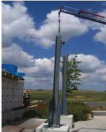
Kiriş yapıların kurulumu
